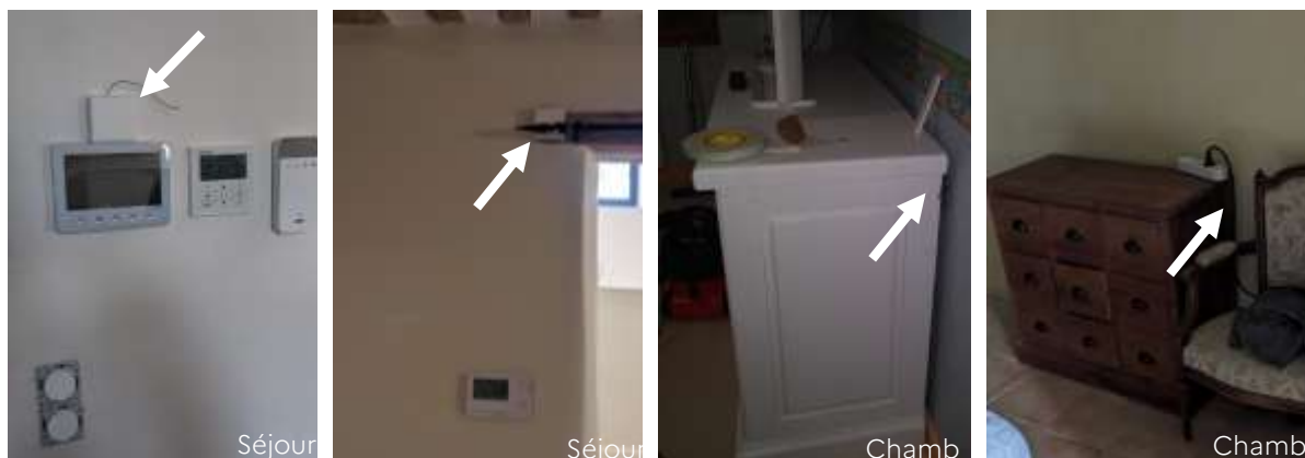
Figure 9 : Exemples de poses de sondes d'ambiances
