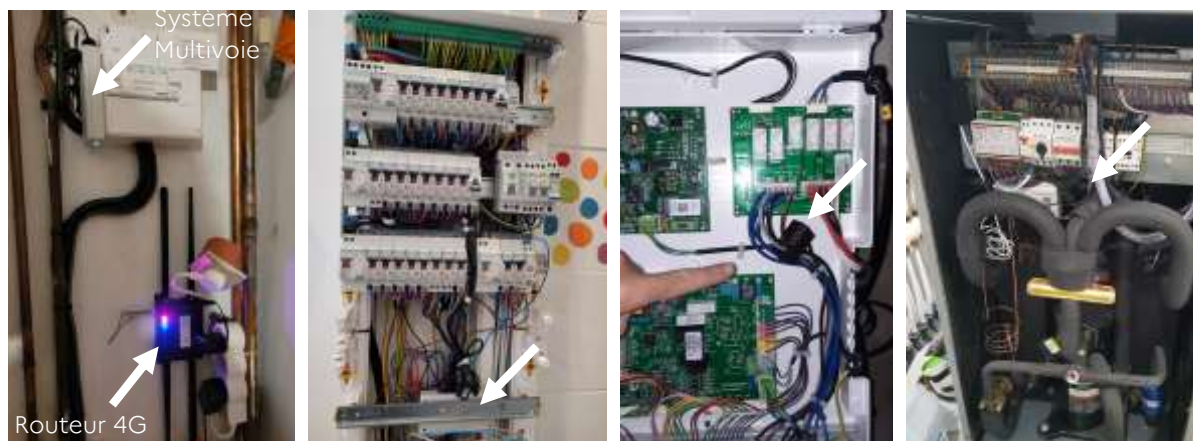
Figure 7 : Exemples de poses des capteurs de consommation électrique
