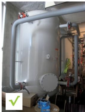
Installation d'un ballon tampon afin de compenser le surdimensionnement du système de chauffage existant.
