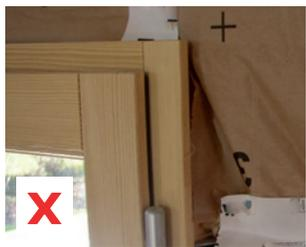
Discontinuité du plan d'étanchéité à l'air au niveau de la jonction entre le châssis (dormant) et la membrane d'étanchéité à l'air.
