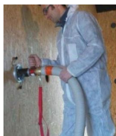
Insufflation isolante en vrac
