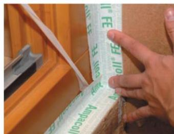
Pont thermique de tableau et d'appui de menuiserie : Privilégier la pose de la menuiserie dans la continuité de l'isolant afin d'éviter les ponts thermiques. Si cela est impossible apporter une correction thermique
