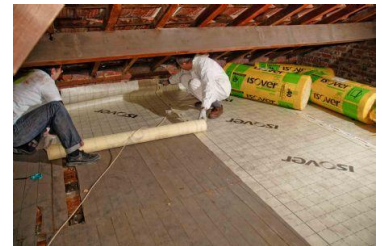
Pose film étanchéité
