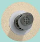
La ventouse rend la chaudière étanche. L'air nécessaire à la combustion est puisé à l'extérieur. Ce type de conduit double flux sert donc à la fois d'aspiration d'air de combustion et d'extraction des fumées.
