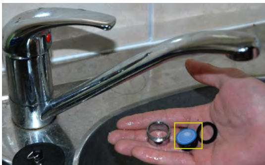
Bague en laiton dévissable, aérateur (en bleu) et joint d'étanchéité
